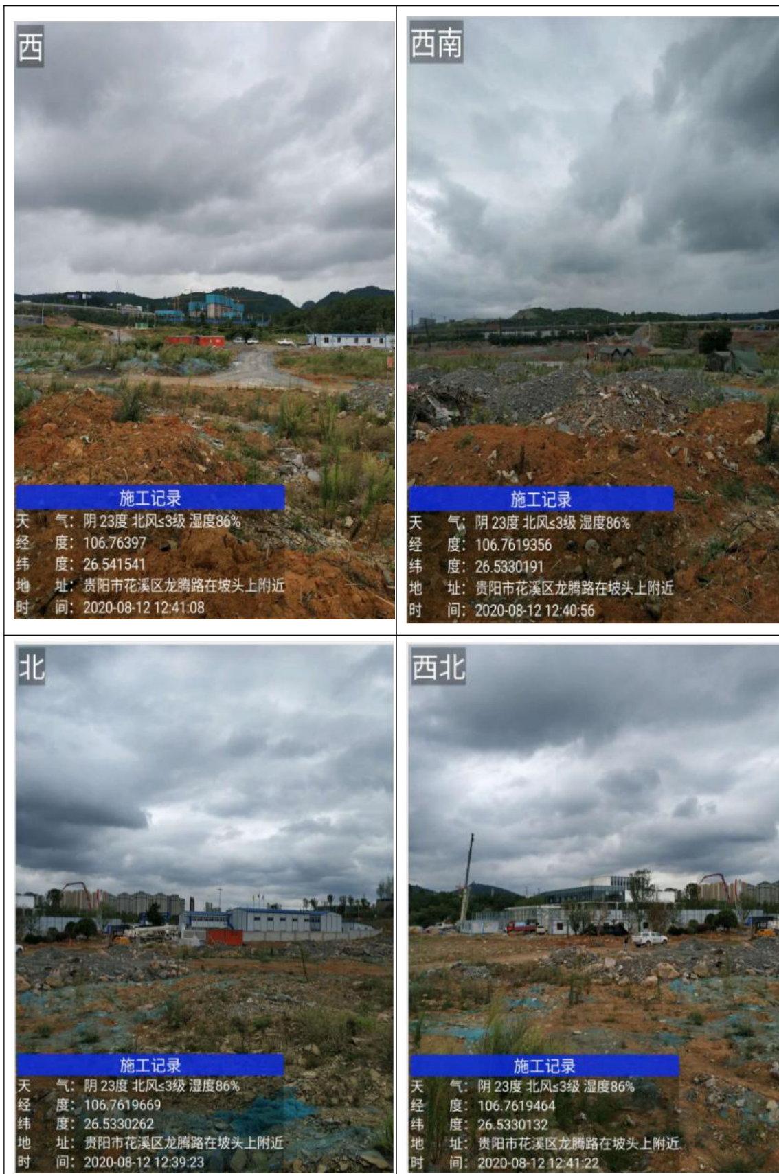
图 2-3 贵州双龙航空港经济区龙腾小学原场地各区域现状情况
